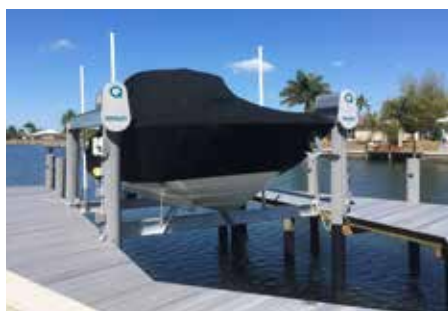
Superlift montert på pæler
